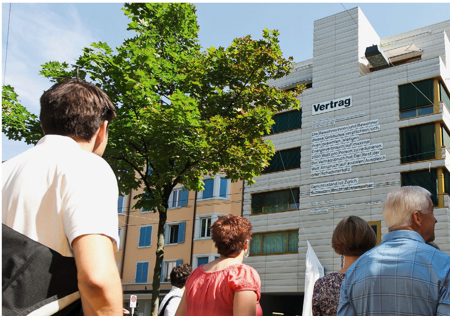
Kunst am Bau: Der «Vertrag» des Trio Superflex an der Badenerstrasse verpflichtet die Bewohner die Ziele der 2000-Watt-Gesellschaft zu erreichen.
