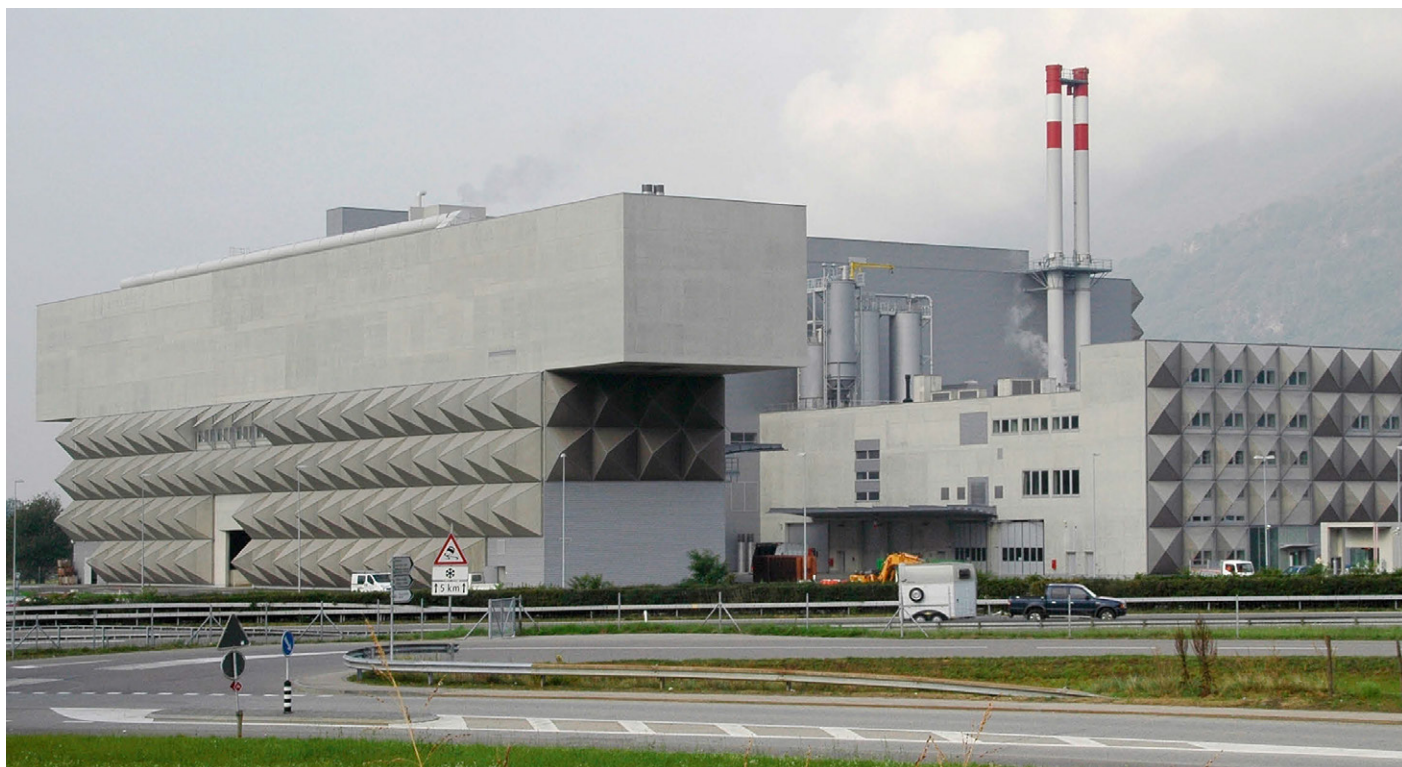
Impianto Cantonale di Termovalorizzazione dei Rifiuti (ICTR) a Giubiasco.
